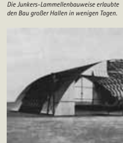
Die Junkers-Lamellenbauweise erlaubte den Bau großer Hallen in wenigen Tagen.
